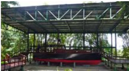
Hemingways Boot auf Kuba, ein typisches Beispiel eines Schutzdachs als freitragende Dachkonstruktion. Bildurheberrechte: Bernhard Mai, 08/2012
