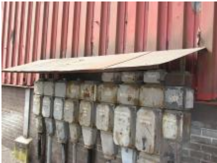
Typisches Schutzdach über einer Elektroanlage im Weltkulturerbe Völklinger Hütte. Bildurheberrechte: Büro für Restaurierungsberatung, 08/2012
