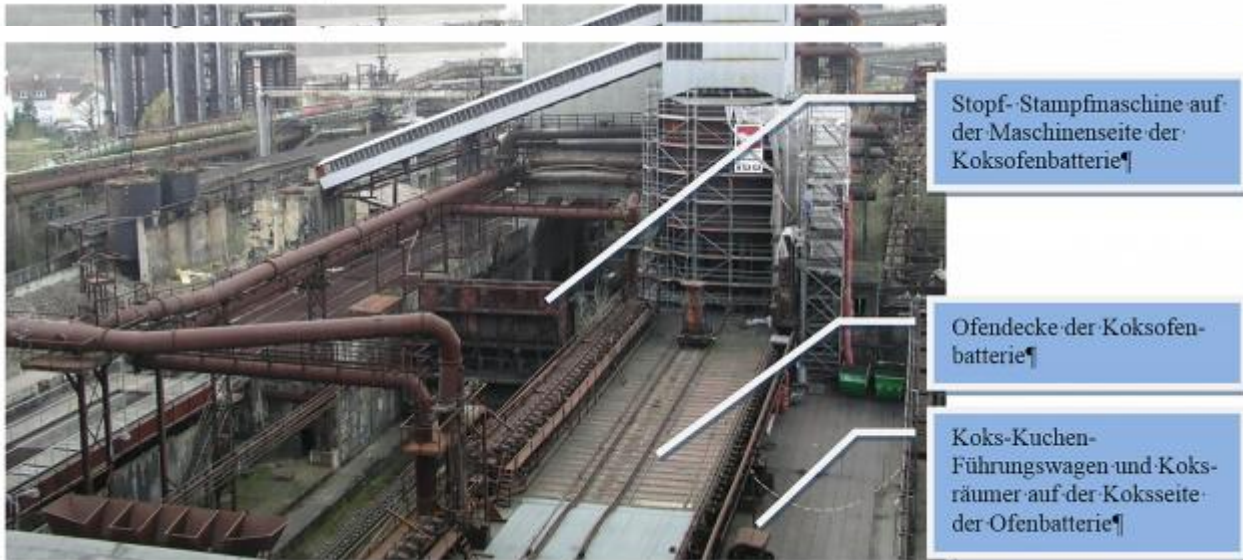
Koksofenbatterie mit Maschinen in der Kokerei im Westfälischen Völklinger Hütte Bildrechte: Büro für Restaurierungsberatung, 2008 Koksofenbatterie mit Maschinen in der Kokerei im Westfälischen Völklinger Hütte Bildrechte: Büro für Restaurierungsberatung, 2008
