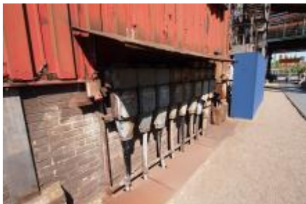
Weltkulturerbe Völklinger Hütte: Erhaltungsziel „Stillstand (Ruine)“ durch einfaches Schutzdach Bildurheberrechte: Büro für Restaurierungsberatung Götz | Lindlar 2012
