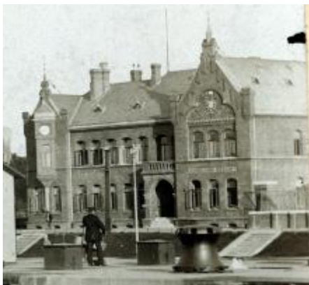
Schleusen des Nord-Ostsee-Kanals in Kiel-Holtenau, Amtsgebäude 1895
