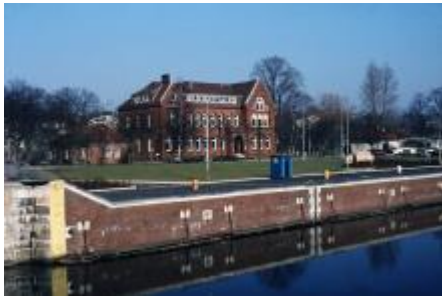
Schleusen des Nord-Ostsee-Kanals in Kiel-Holtenau, Amtsgebäude mit den Umbauten aus dem 1950er Jahren (undatiertes Foto nach 1950)
