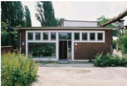
Beispiel Umnutzung - Das Säurelager im Landschaftspark Duisburg-Nord 2001 Bildurheberrechte: planinghaus architekten bda
