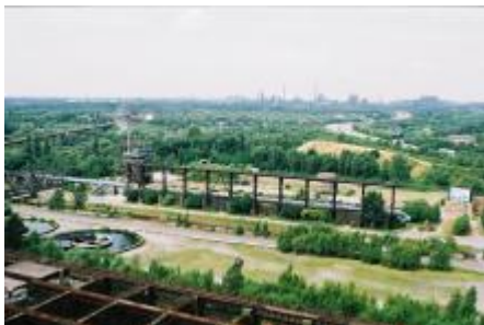
Beispiel Rückbau - Die Sinteranlage im Landschaftspark Duisburg-Nord 2001. Bildurheberrechte: planinghaus architekten bda
