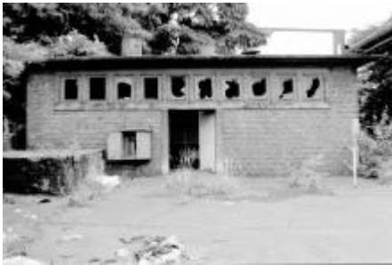
Beispiel Umnutzung - Das Säurelager im Landschaftspark Duisburg-Nord 1990. Bildurheberrechte: planinghaus architekten bda
