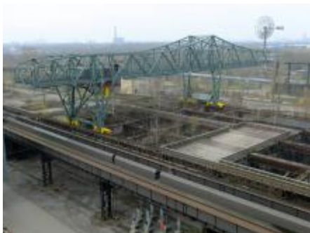
Beispiel Konservierung - Die Verladebrücke der Erzbunkeranlage im Landschaftspark Duisburg-Nord 2001. Bildurheberrechte: planinghaus architekten bda
