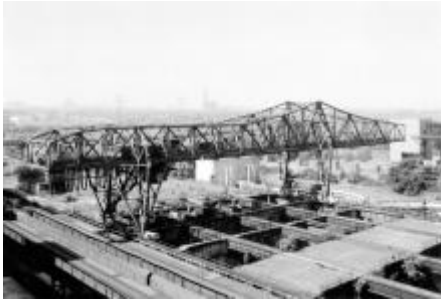
Beispiel Konservierung - Die Verladebrücke der Erzbunkeranlage im Landschaftspark Duisburg-Nord 1990. Bildurheberrechte: planinghaus architekten BDA
