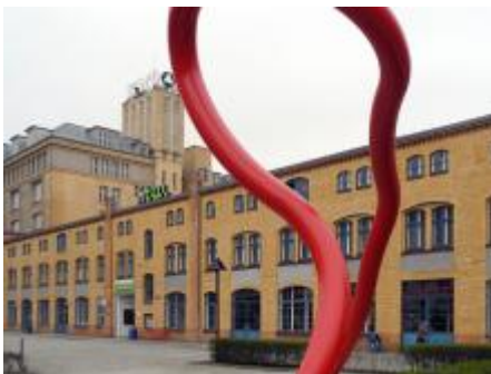
Hochschule für Technik und Wirtschaft auf dem Gelände des ehemaligen AEG Kabelwerks Oberspree Berlin. Im Bild die ehemalige Fabrik für Fahrzeugteile und Verwaltung; Copyright Heike Oevermann Bildurheberrechte: Heike Oevermann
