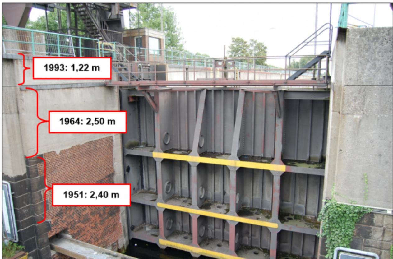
Bauphasen an der Nordschleuse Wanne-Eickel des Rhein-Herne-Kanals (Aufstockungen aufgrund von Geländeabsenkungen durch den Bergbau) Bildurheberrechte: WSV Bund
