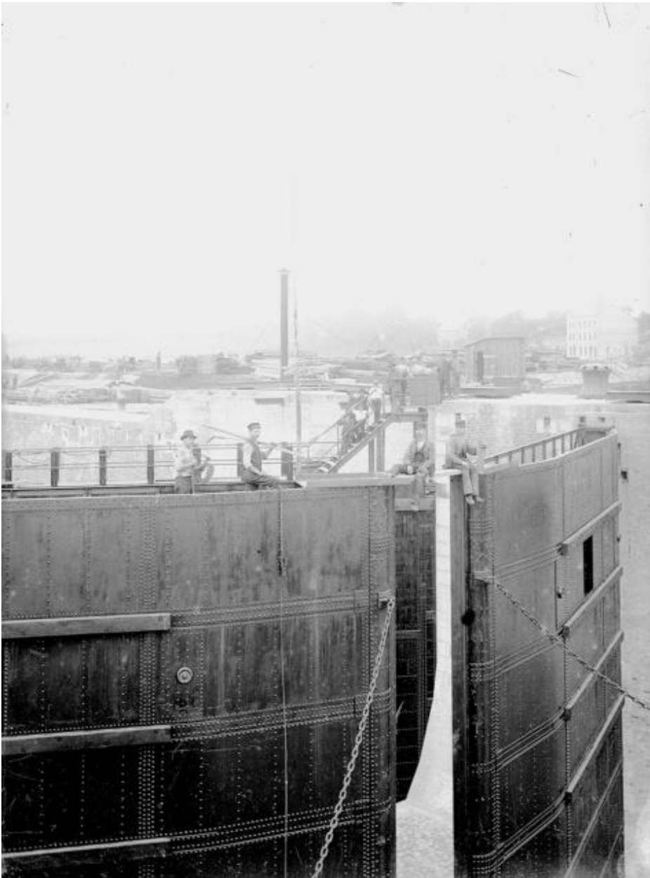
Schleusen des Nord-Ostsee-Kanals in Kiel-Holtenau, Einbau der Schleusentore 1894
