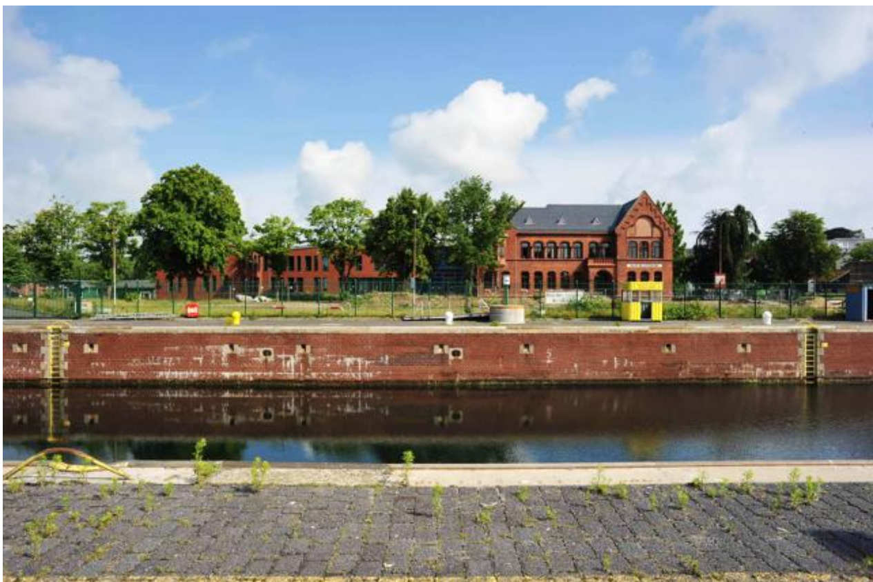
Schleusen des Nord-Ostsee-Kanals in Kiel-Holtenau, Amtsgedäude 2016
