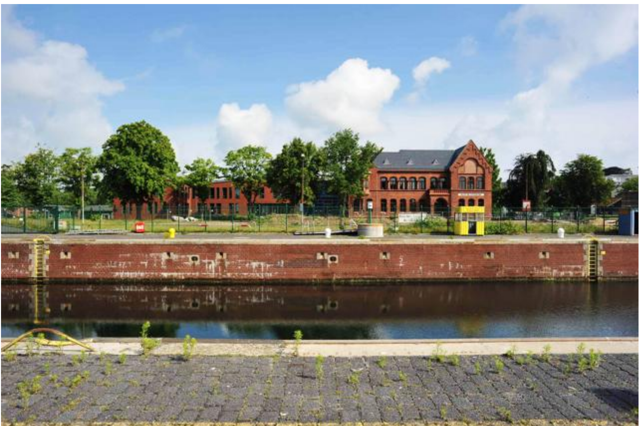
Schleusen des Nord-Ostsee-Kanals in Kiel-Holtenau,
