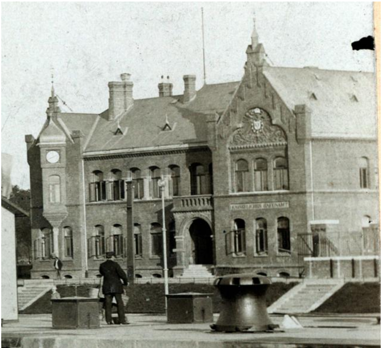
Schleusen des Nord-Ostsee-Kanals in Kiel-Holtenau, Amtsgebäude 1895
