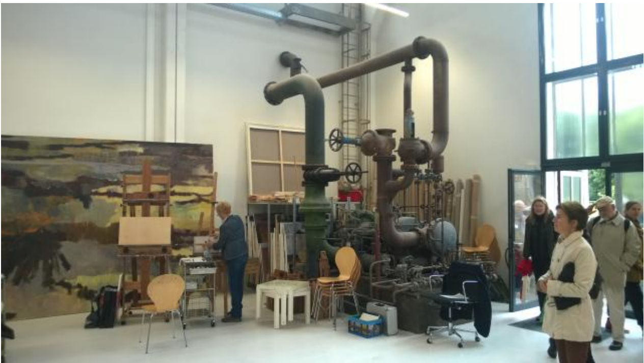
Nach der Umnutzung: Pumpenhaus 1 als Showroom, (Zeche Zollverein, Kokerei (Weiße Seite), Kammgebäude, Aufnahme
