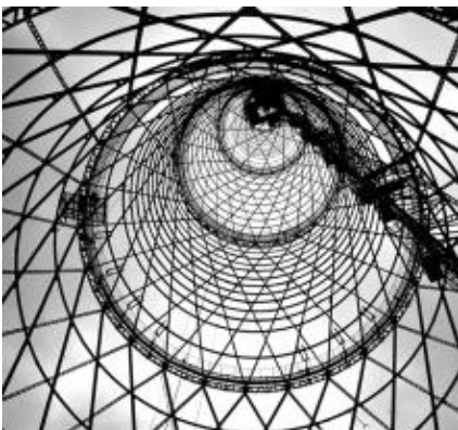
Abbildung 2: Šabolovka- Fernmeldeturm, Moskau; Addition von Hyperboloiden mit 150
