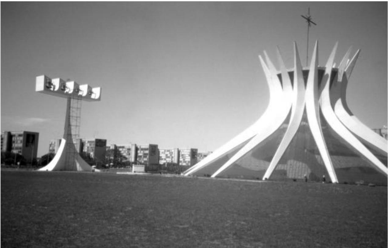
Abbildung 27: Kathedrale von Brasilia, Bauhöhe 40 m, bestehend aus 16 Betonhohlrippen
