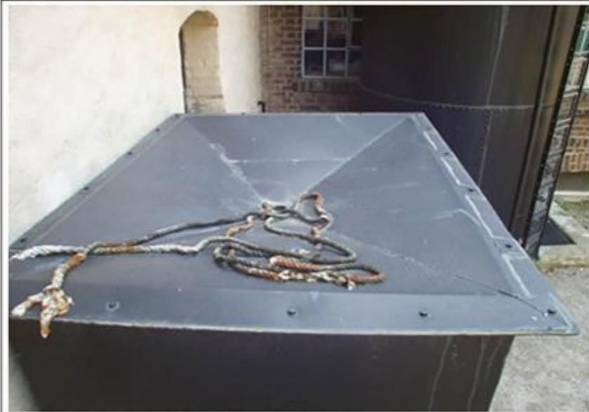
Integrierte Schutzabdeckung aus Blech mit Innenablauf .
