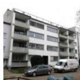
Siedlung Dammerstock, Danziger Straße 12-14, Karlsruhe (ehem. Ludwig-Braun-Straße 12-14)
