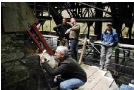
Handnahe Zustandserkundung, LWL-Industriemuseum Schiffshebewerk Henrichenburg Bildurheberrechte: Norbert Tempel
