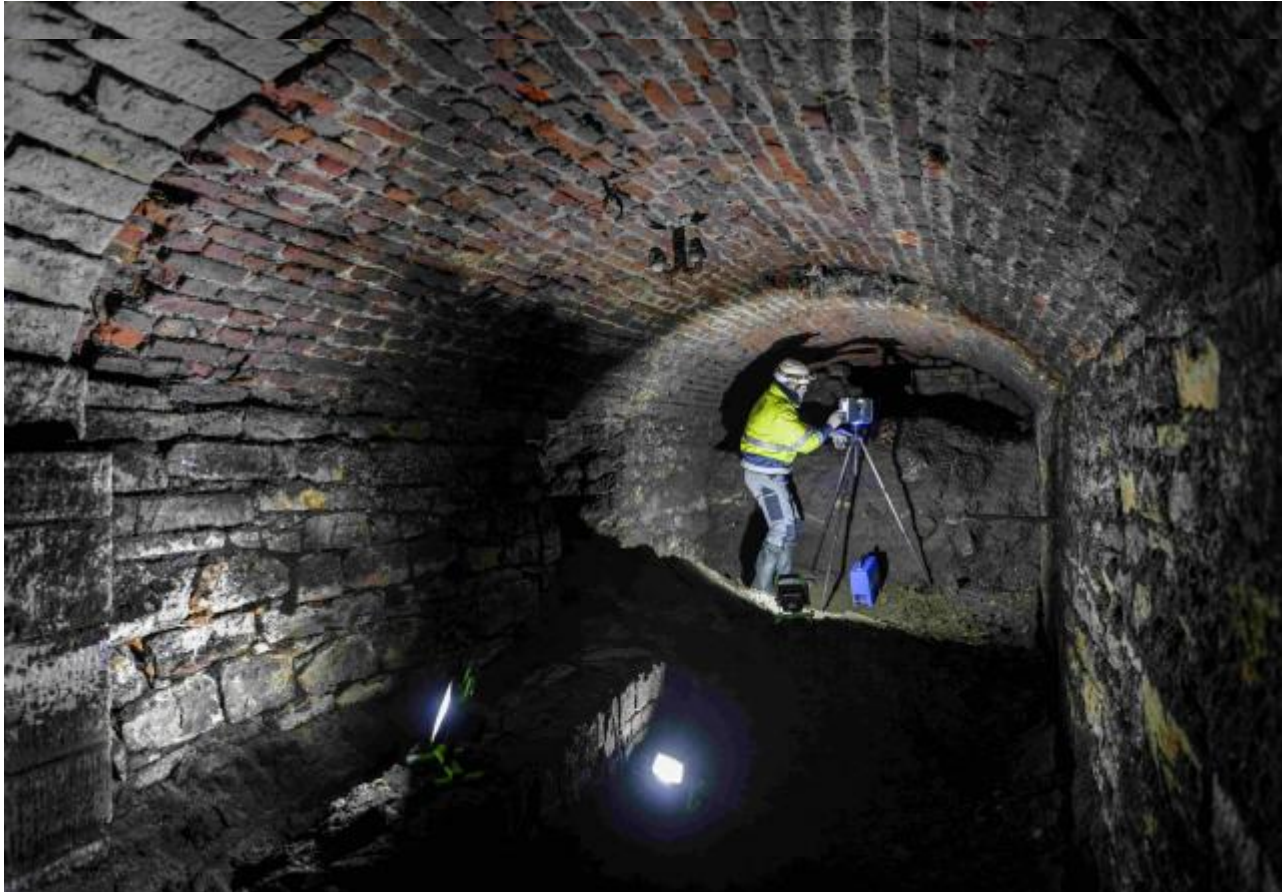
Erkundung eines ehem. Pferdebahn-Tunnels der Henrichshütte in Hattingen mittels 3D-Scanning, 2016
