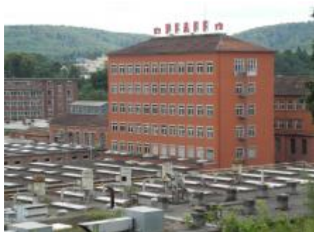
Pfaff Areal Kaiserslautern, Deutschland Bildurheberrechte: Heike Oevermann
