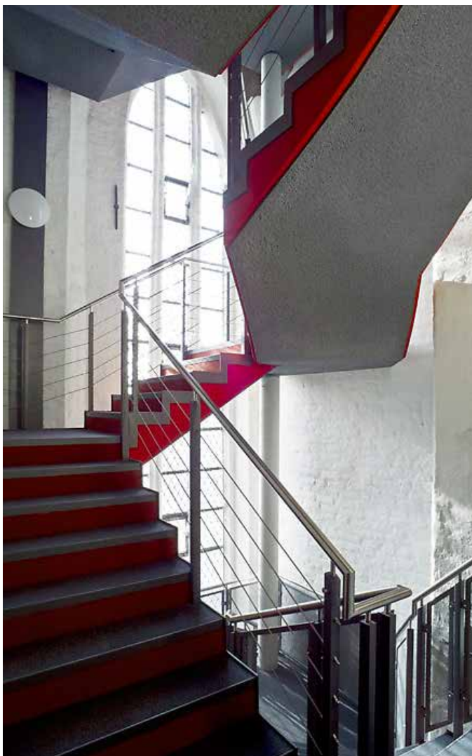
Einfügung eines neuen Treppenhauses als zweiter Rettungsweg
