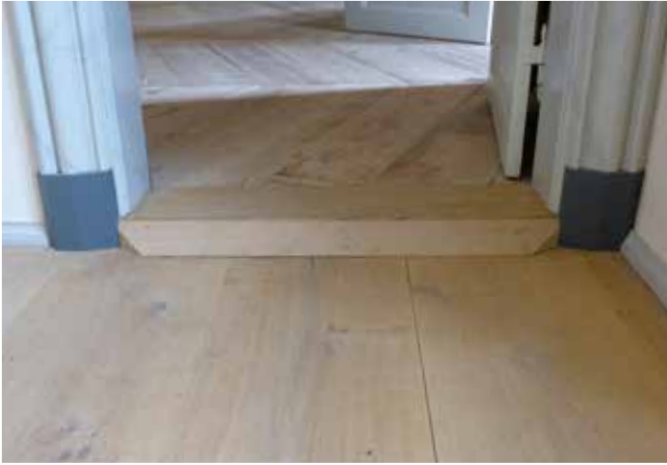
Barrierefreie Rettungswegführung durch angepasste neue Schwelle
