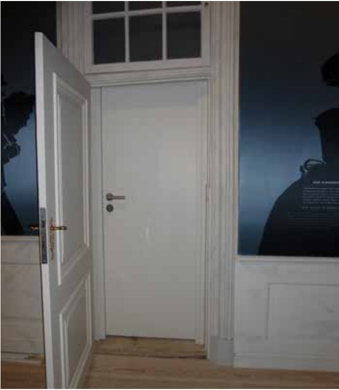
Feuerschutztür mit Zustimmung im Einzelfall (ZiE)
