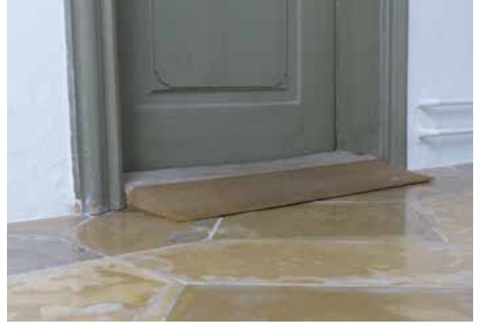
Barrierefreie Rettungswegführung durch hinzugefügten Keil
