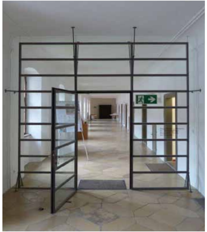
Brandabschnittsbildung innerhalb eines öffentlichen Gebäudes
