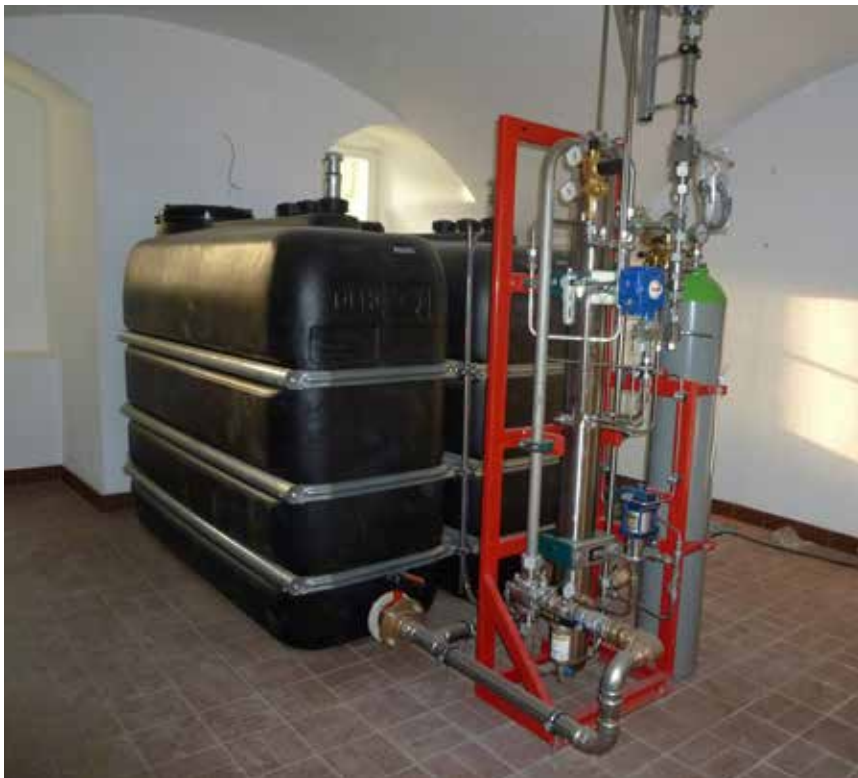
Hochdruckwassernebellöschanlage
