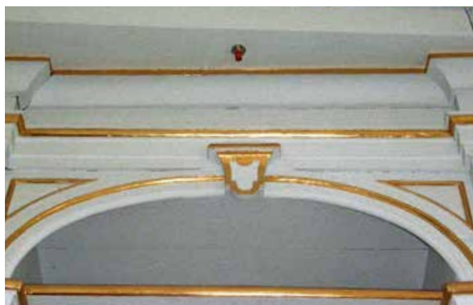
Löschdüse einer Hochdrucknebellöschanlage
