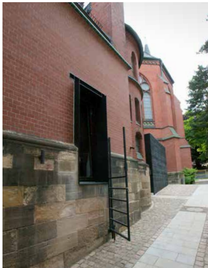
Das herabgelassene Fenstergitter dient im Evakuierungsfall als Ausstiegsleiter zur Selbstrettung
