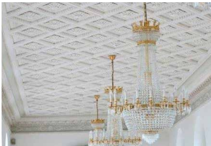
In aufwändig gestalteter Stuckdecke nahezu unscheinbar integrierte Rauchmelder
