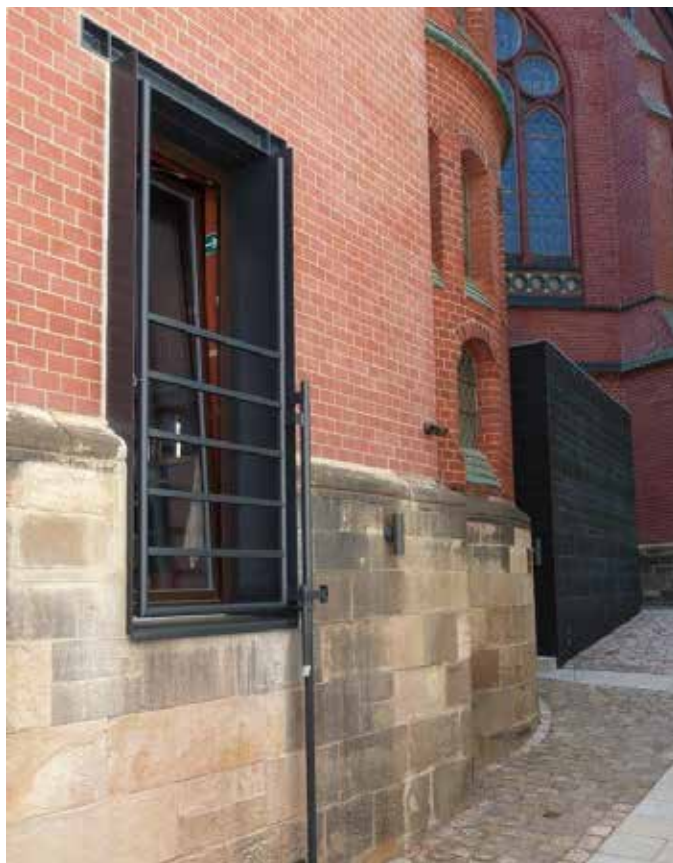
Ansprechend gestaltete Fensteröffnung
