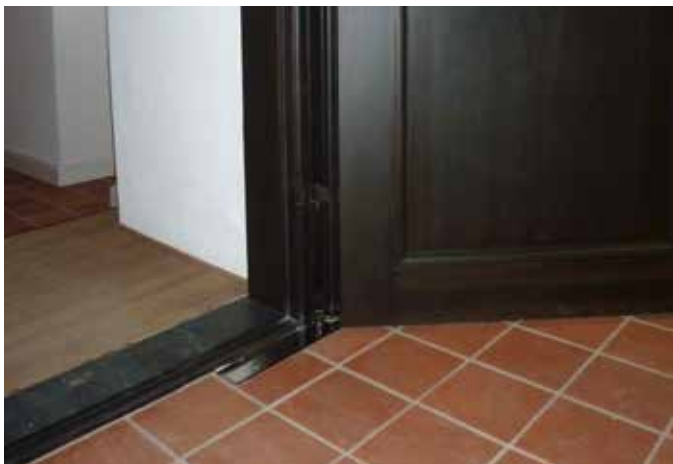
Untertürschließer in Bestandstür
