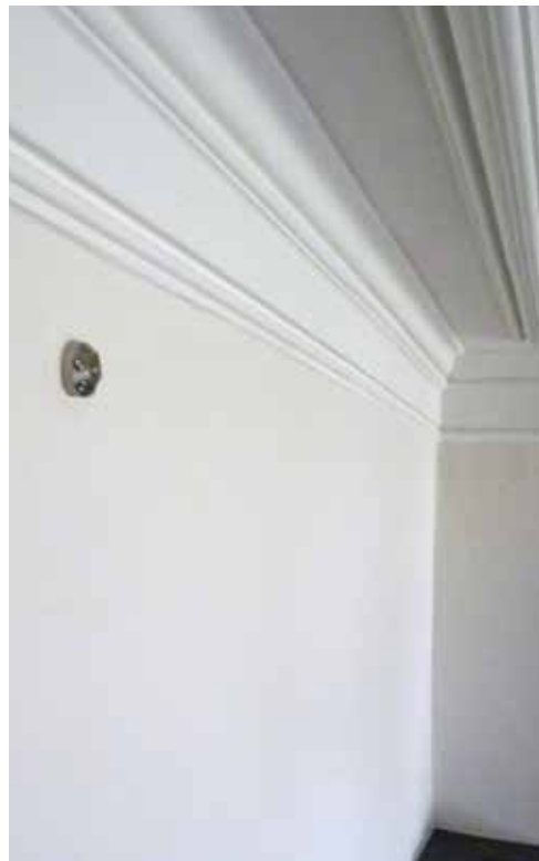
Löschdüse Hochdruckwassernebellöschanlage
