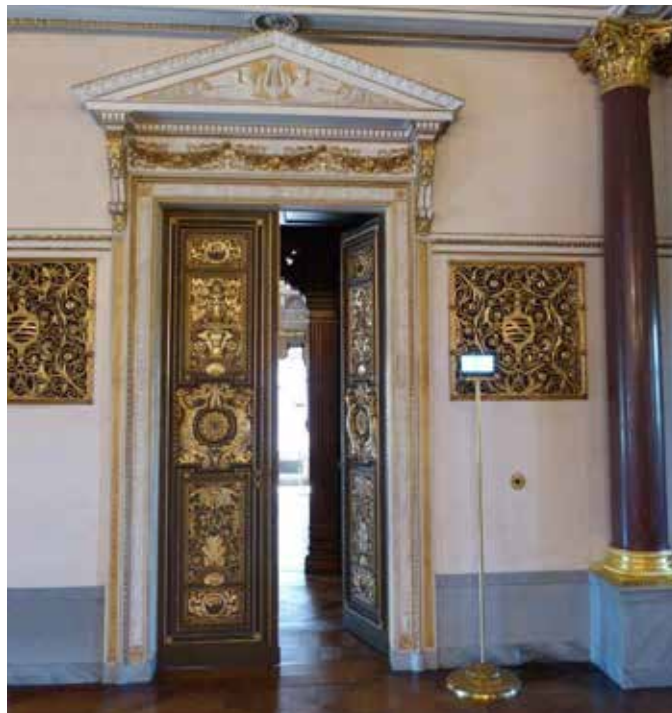
Aufstellung eines über Fußleistenanschluss festinstallierten Fluchtwegschildes zur Vermeidung baulicher Eingriffe in den sensiblen Denkmalbestand
