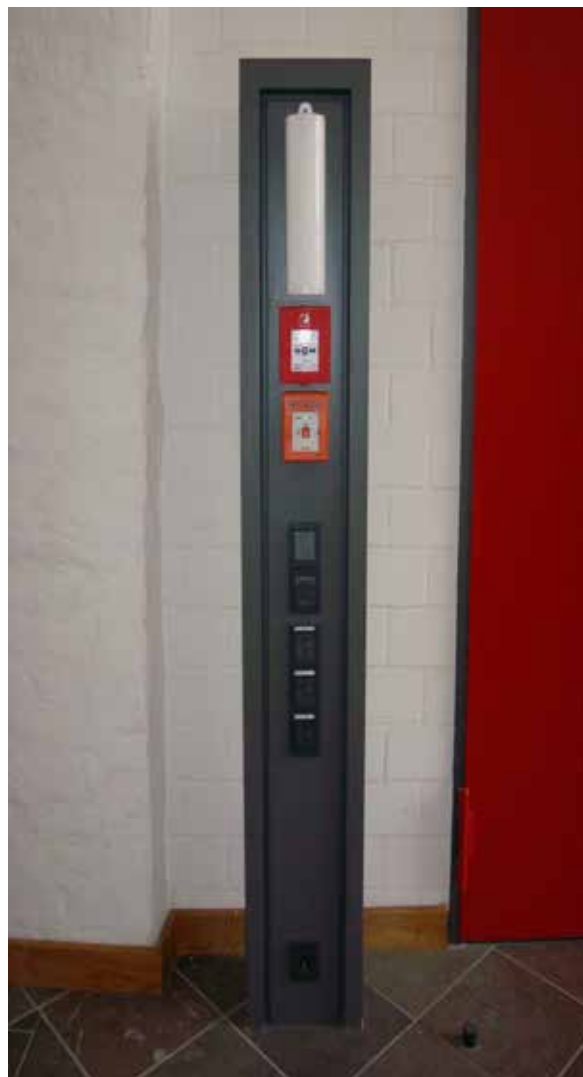
Stele mit Elektrofunktionen, einschliesslich Brandmelder
