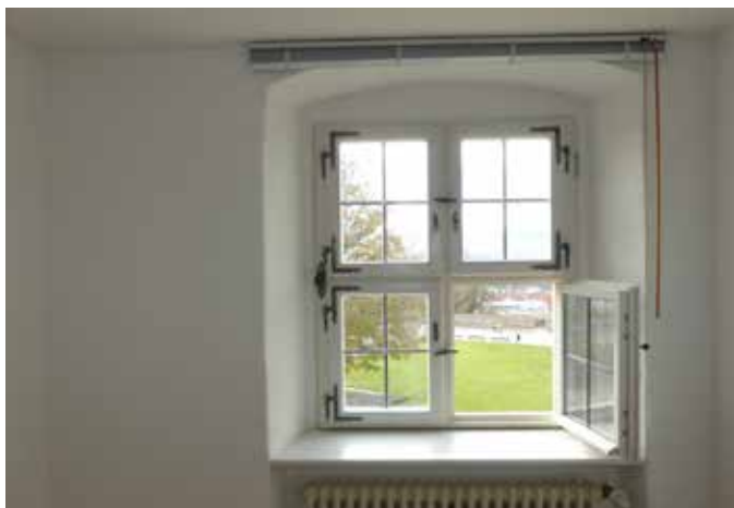
Fenster als Anleiterstelle
