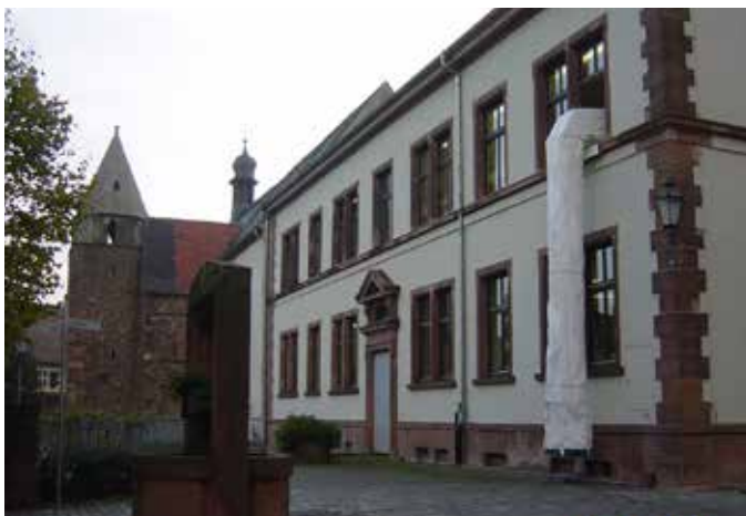
Personenrettungsschlauch als zweiter Rettungsweg
