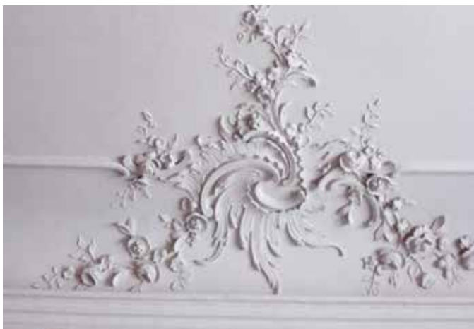
Kaum sichtbare Öffnung eines Rauchansaugsystems
