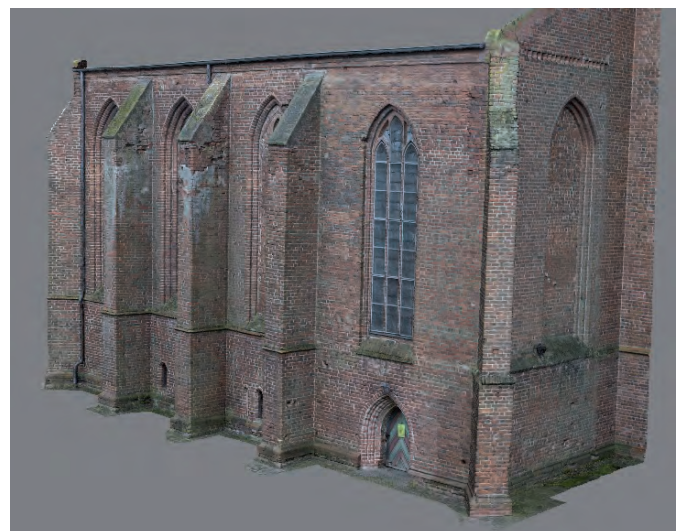
Abb. 9. Beeskow, Sakristei der Marienkirche, fotogrammetrisch berechnete 3D-Oberfläche für Orthofotos.
