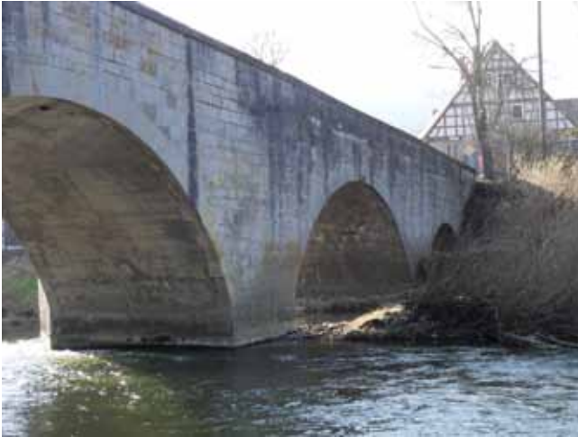
Abb. 7: Straßenbrücke in Mulfingen über die Jagst: Hier wurden alle Bogenuntersichten als Bildplan abgewickelt dargestellt.
