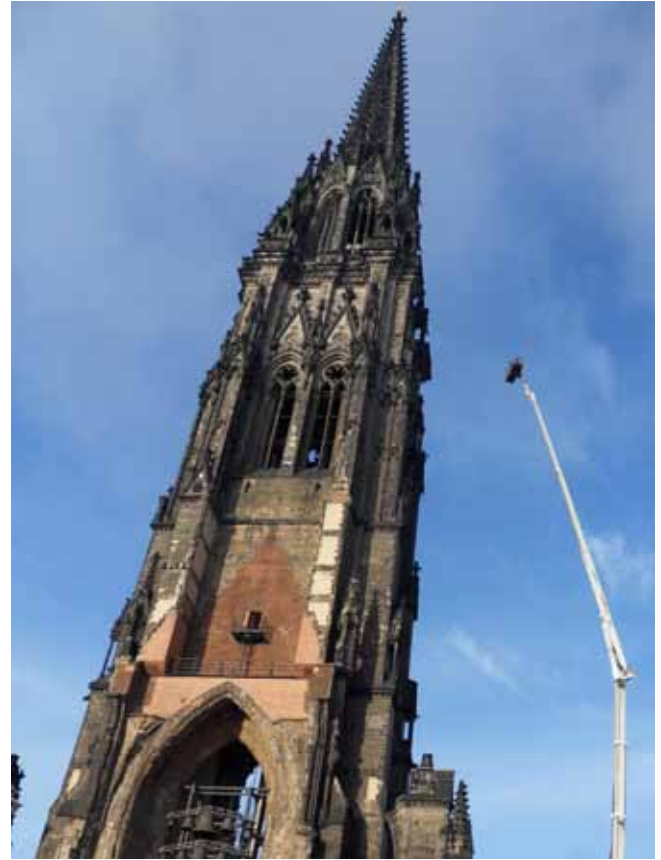
Abb. 13 (rechts und oben): Einsatz einer 88 m-Arbeitsbühne am Nikolaikirchturm in Hamburg. Für den oberen Teil der 147 m hohen Turmspitze wurde ein Helikopter eingesetzt.
