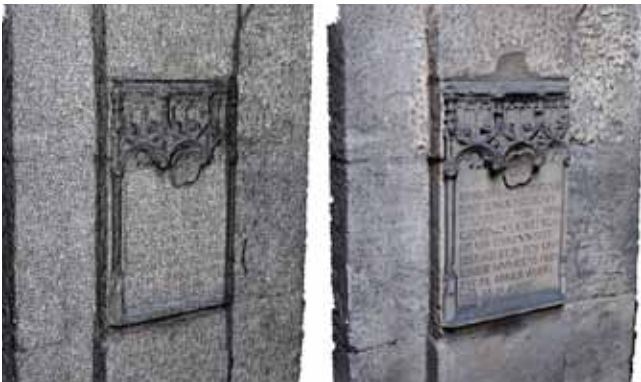
Abb. 19: 3D-Bild eines Epitaphs in hoher Auflösung – links das vermaschte 3D-Oberflächenmodell, rechts das texturierte 3D-Modell; verwendet wurden neun Digitalaufnahmen
