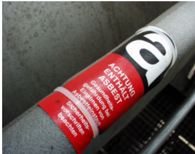
3 Asbestkordel an einem Fernwasserstandsanzeiger: links im unbehandelten Vorzustand, rechts nach der Ummantelung und Kennzeichnung als Gefahrstoff
